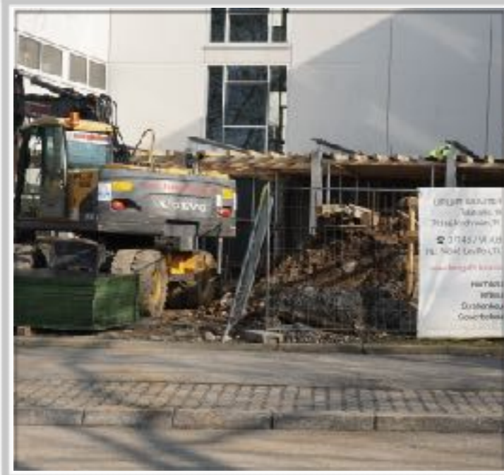
Anbau bis Sommer 2018
